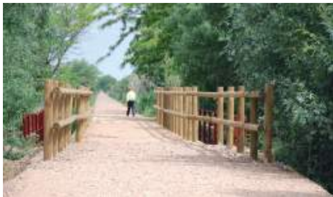
Camino en obras en la zona de Villanueva de Azoague
